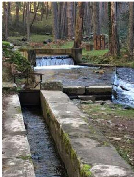
**Fig. 4** - Conducción a cielo abierto
