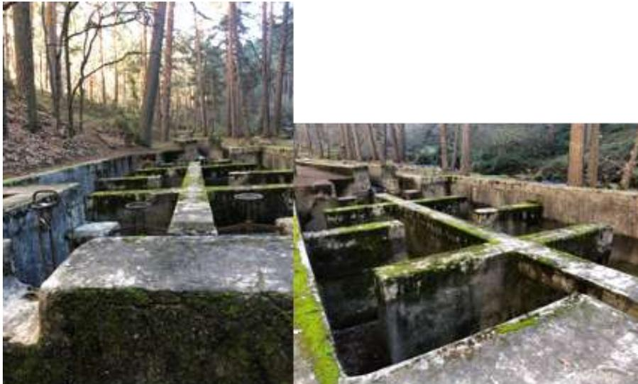
**Fig. 3** - Primera captación de aguas; Decantación y desarenación en origen
